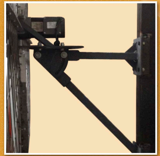
Mecanismo ajustable con movimiento vertical y horizontal,
